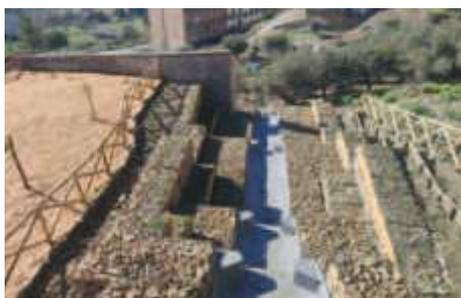
✓ Messa in sicurezza versante dell’abitato a valle della **Via Nazionale** (Corso Enna) mediante interventi di consolidamento con realizzazione di opere di sostegno e trincee drenanti. Lavori ultimati.
