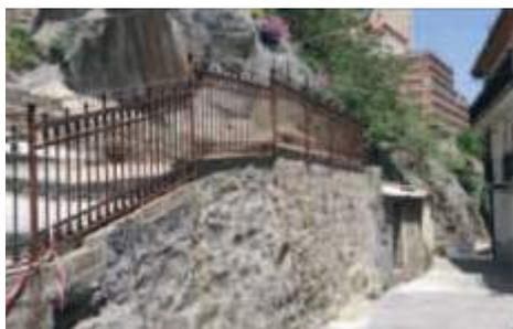
✓ *Ricostruzione di tratti di muri nella **Via Angelica, Via Delle Stelle** e versante in **Via Rocche**, dissestati a seguito degli eventi atmosferici calamitosi. Lavori ultimati.*
