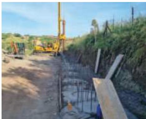
✓ *Messa in sicurezza del versante in **contrada Castile** frana catalogata al PAI n. 045 4TR 076, mediante la realizzazione di trincee e pozzi drenanti, opere di contenimento e sistemazione idraulica forestale. Lavori ultimati.*
