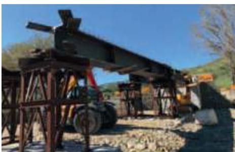
✓ Mitigazione del dissesto idraulico mediante la sistemazione dell'attuale attraversamento a guado nel **fiume Troina** mediante la realizzazione di un ponte di 2<sup>a</sup> categoria. Lavori di fase di ultimazione.
